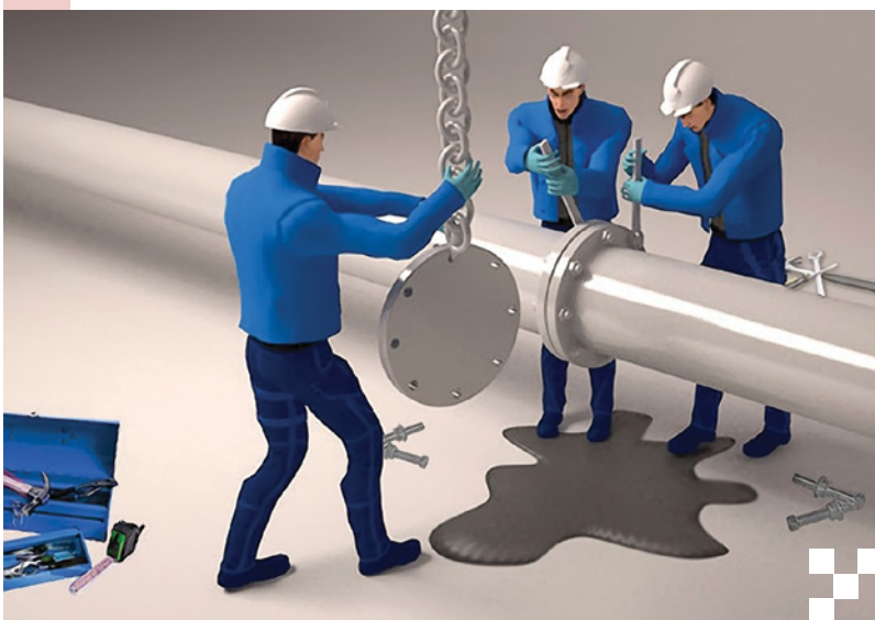
Bloqueo absoluto mediante método convencional (brida ciega).
