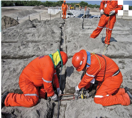
Figura 6. Instalación de la cama anódica.
