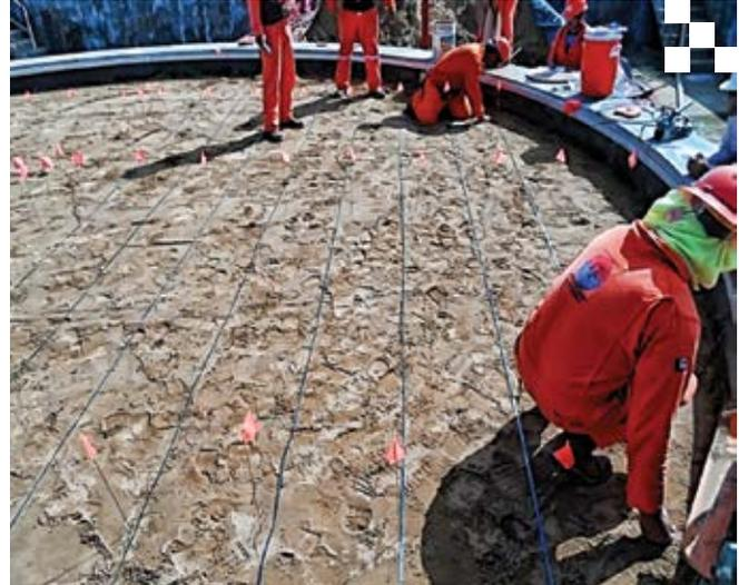
Figura 2. Anillo de concreto y arena como material de relleno para el desplante del soporte del tanque.
