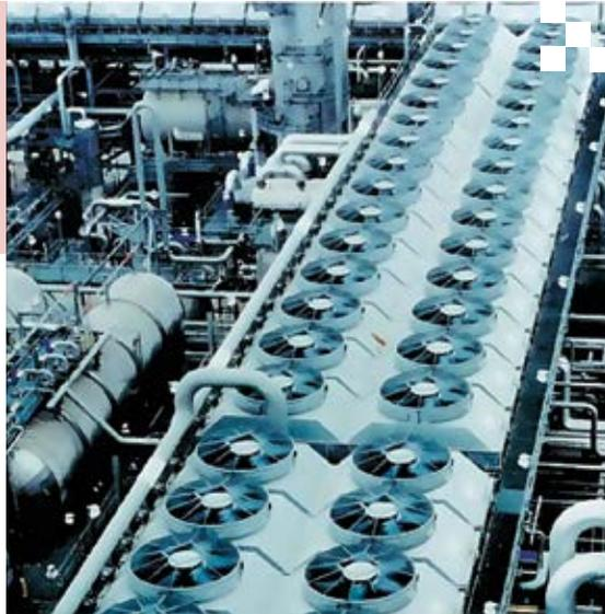
La recirculación de aire caliente es un problema constante en muchas plantas. Se crean diferencias de temperatura que reducen el rendimiento de los equipos. En temporada de invierno, algunos aerofriadores generan una recirculación de aire en forma deliberada a través de rejillas para evitar congelamientos en el haz de tubos (recirculación de aire caliente).
