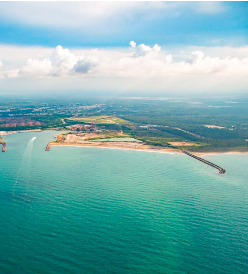
Tabasco atraviesa por una excelente coyuntura energética. A través del desarrollo del puerto de frontera, se espera poder ofrecer a las operadoras la infraestructura requerida.
