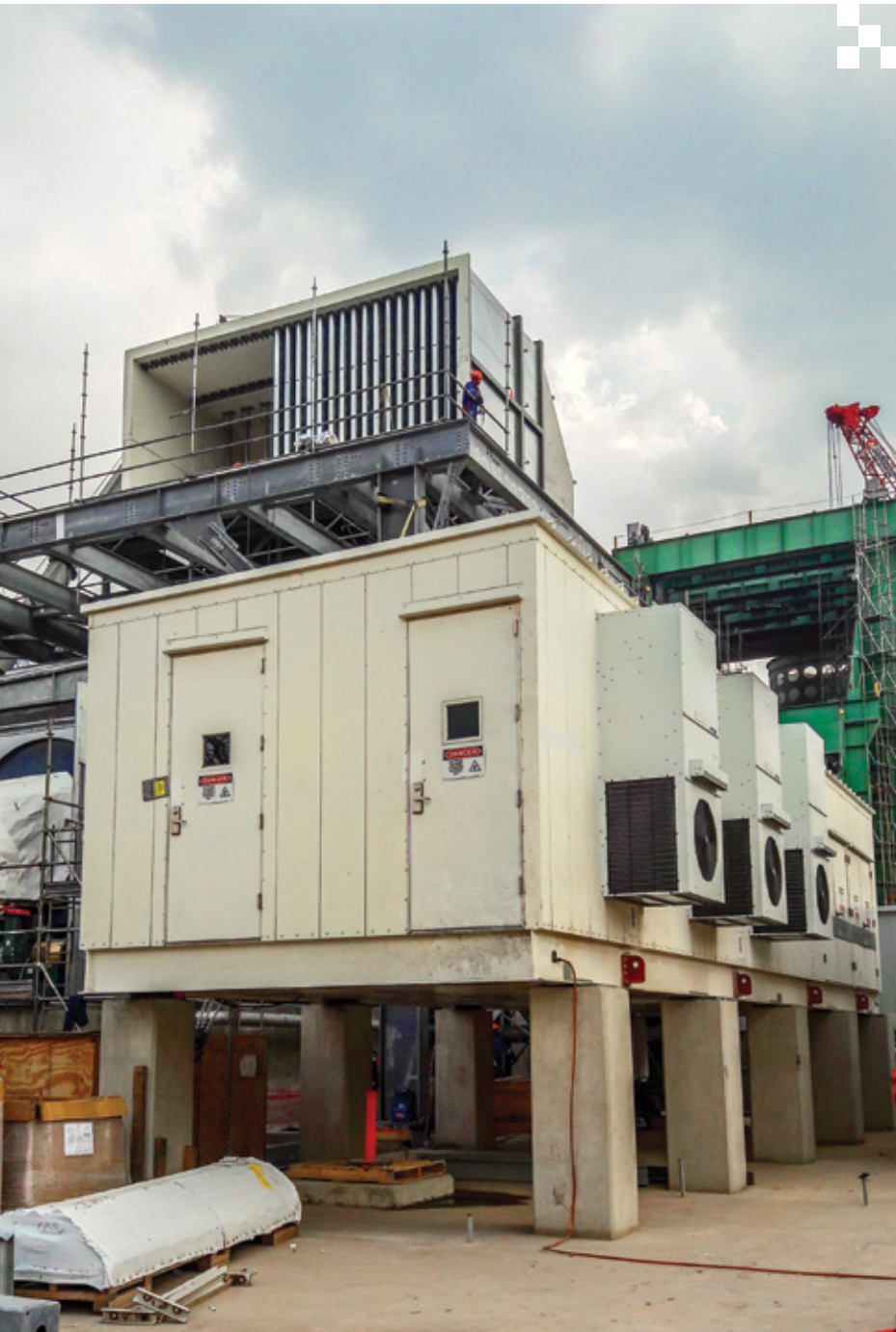
Siemens en consorcio con Grupo Avanzia trabajan con CFE en la modernización de la central termoeléctrica Valle de México.
