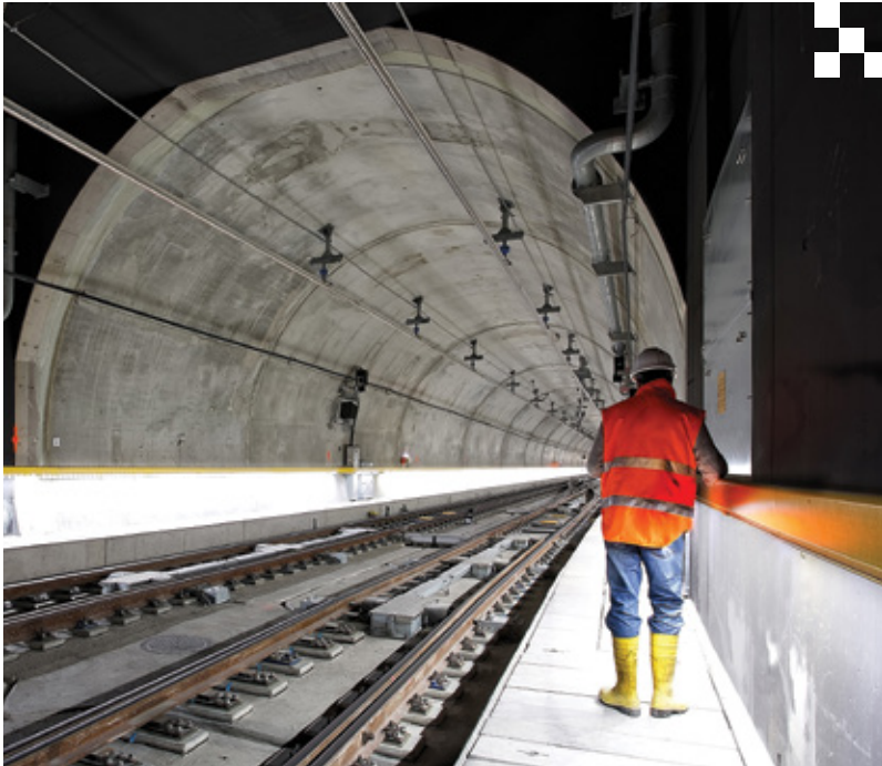
La digitalización permitirá a los clientes y a los operadores de sistemas eléctricos, controlar dónde, cuándo y cómo se utiliza la electricidad.
