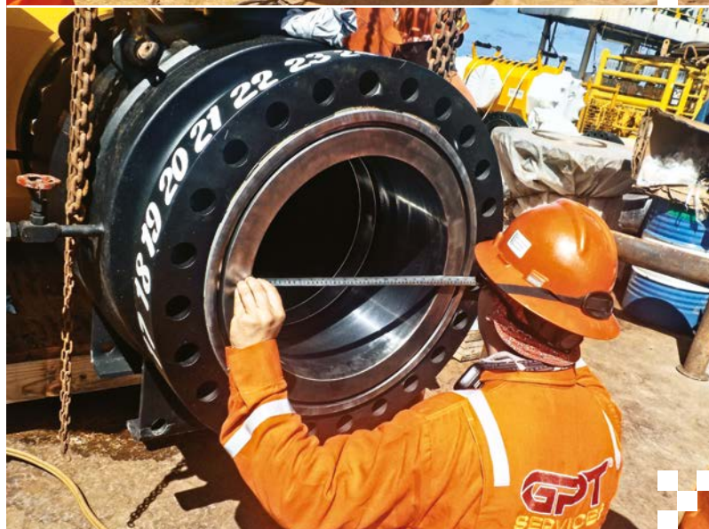
Personal de GPT Services® verificó los bores y dimensiones de las válvulas y las tees, para considerarlos en los cálculos, previo a la ejecución de los trabajos.
