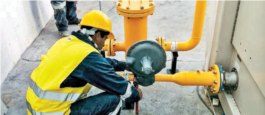
*Las tuberías expuestas poseen la ventaja de tener costos significativamente bajos en ingeniería, permiten una inspección visual rápida de daños y una reparación ágil.*
