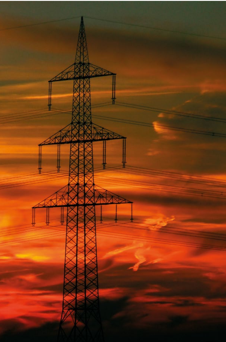
La expansión de la red de transmisión de energía se efectúa conforme a la magnitud y dispersión geográfica de la demanda, así como a la localización de las centrales eléctricas.
