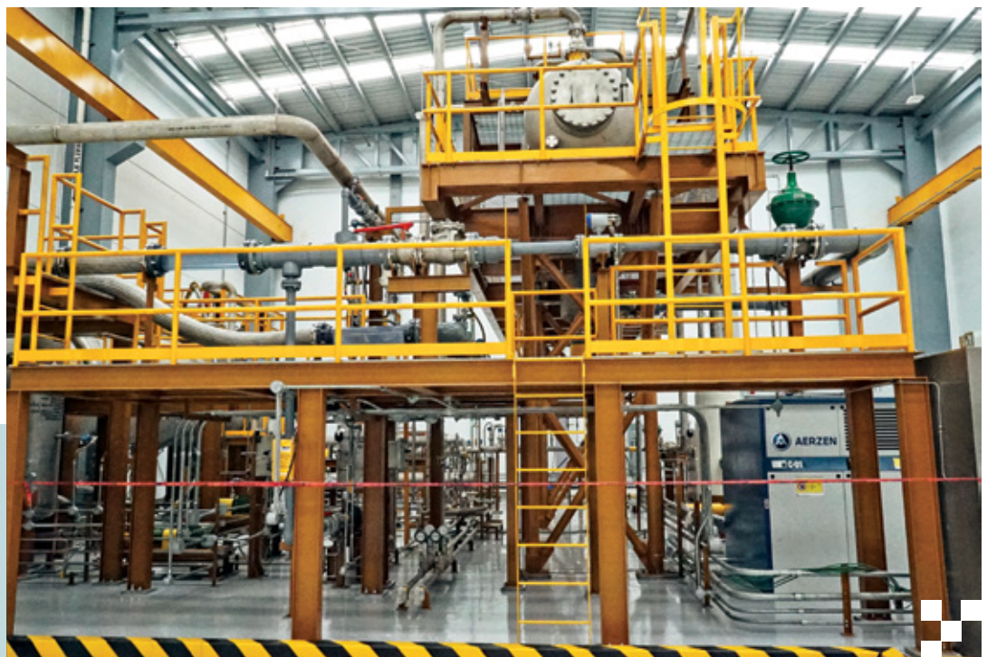
En el loop de baja presión del LCT, las tecnologías o equipos que se requieran calificar, pueden adaptarse a cualquiera de los tres circuitos de prueba, gracias a su infraestructura modular.
